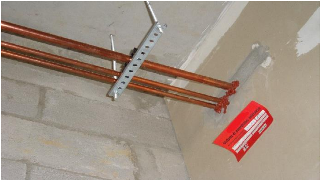
Рисунок 4 – Применение огнестойкого герметика для заделки места проходки трубопроводов медицинских газов в защитном футляре (гильзе)
