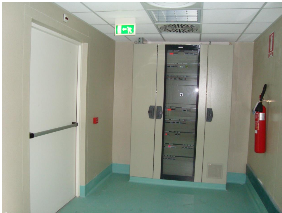
Рисунок 21 – Примеры дверей эвакуационных выходов с устройством «Антипаника»
