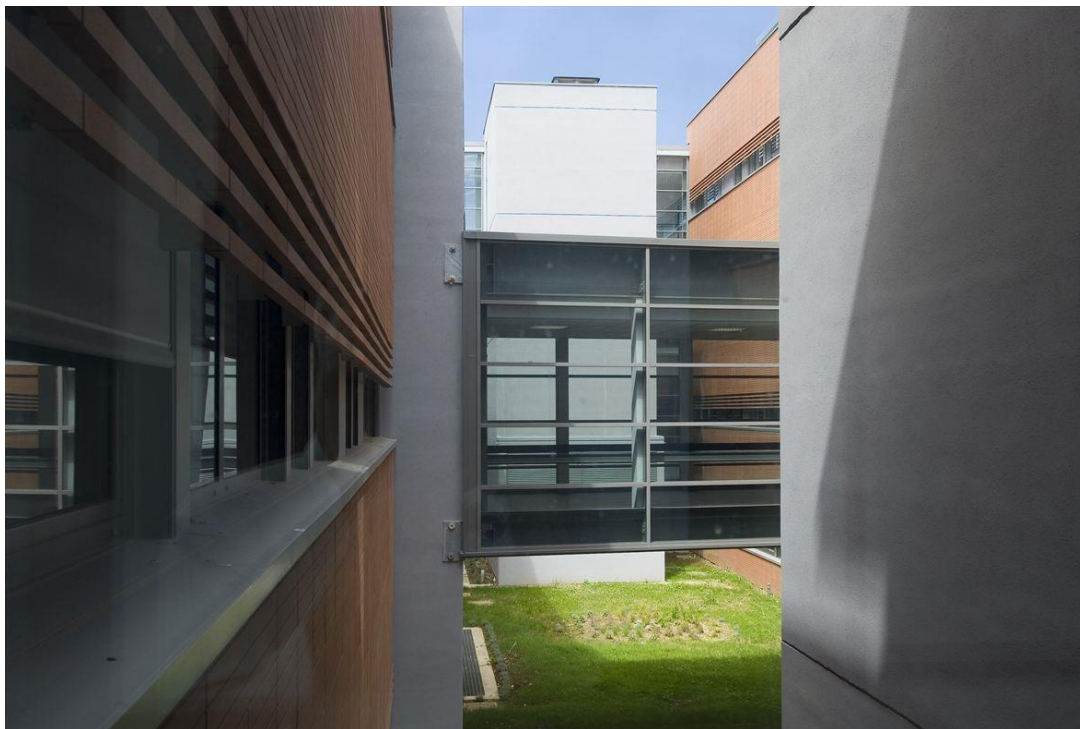
Рисунок 7 – Пример перехода между корпусами больницы
