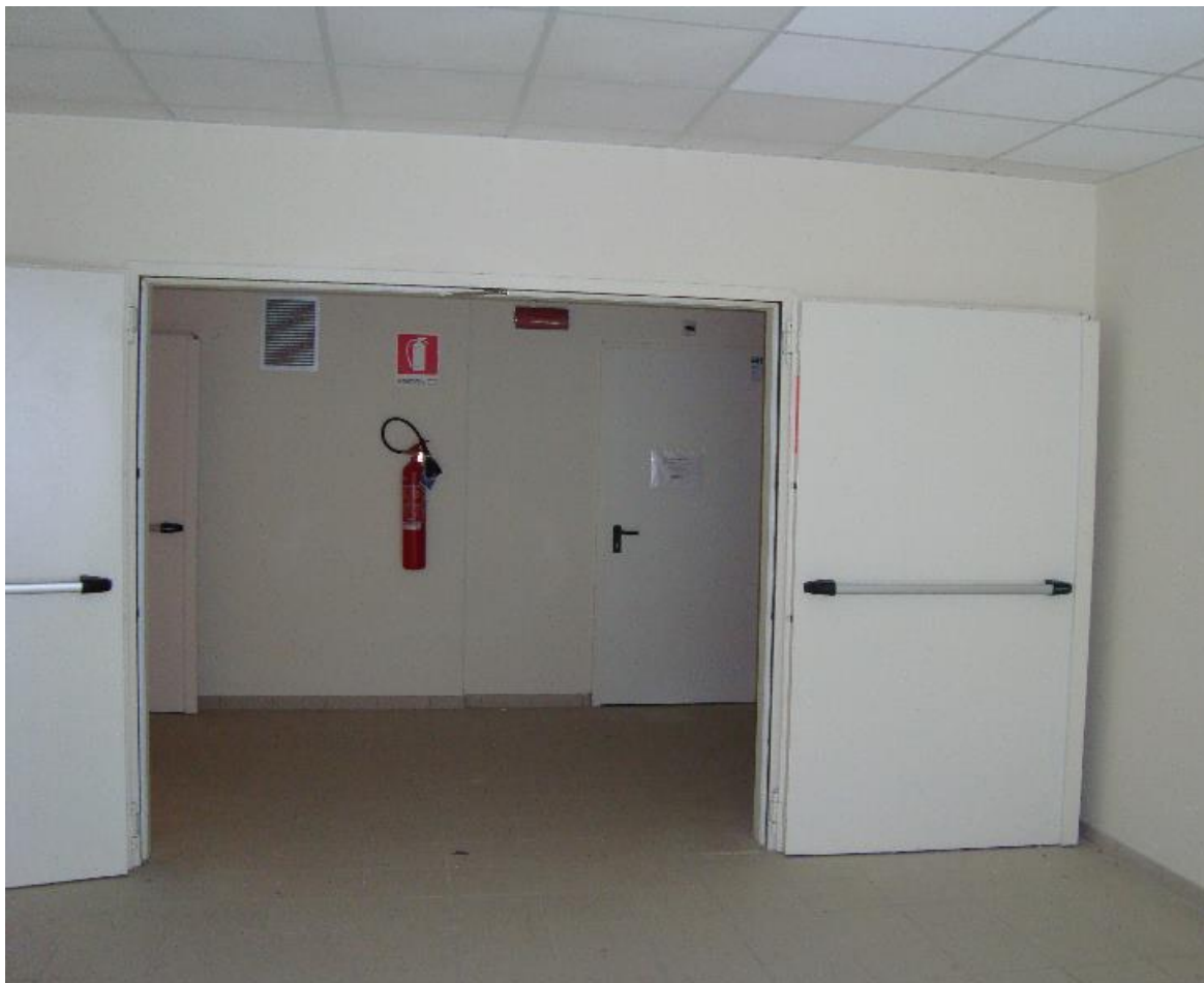
Рисунок 22 – Пример противопожарных самозакрывающихся дверей с автоматическим устройством фиксирования их в открытом положении
